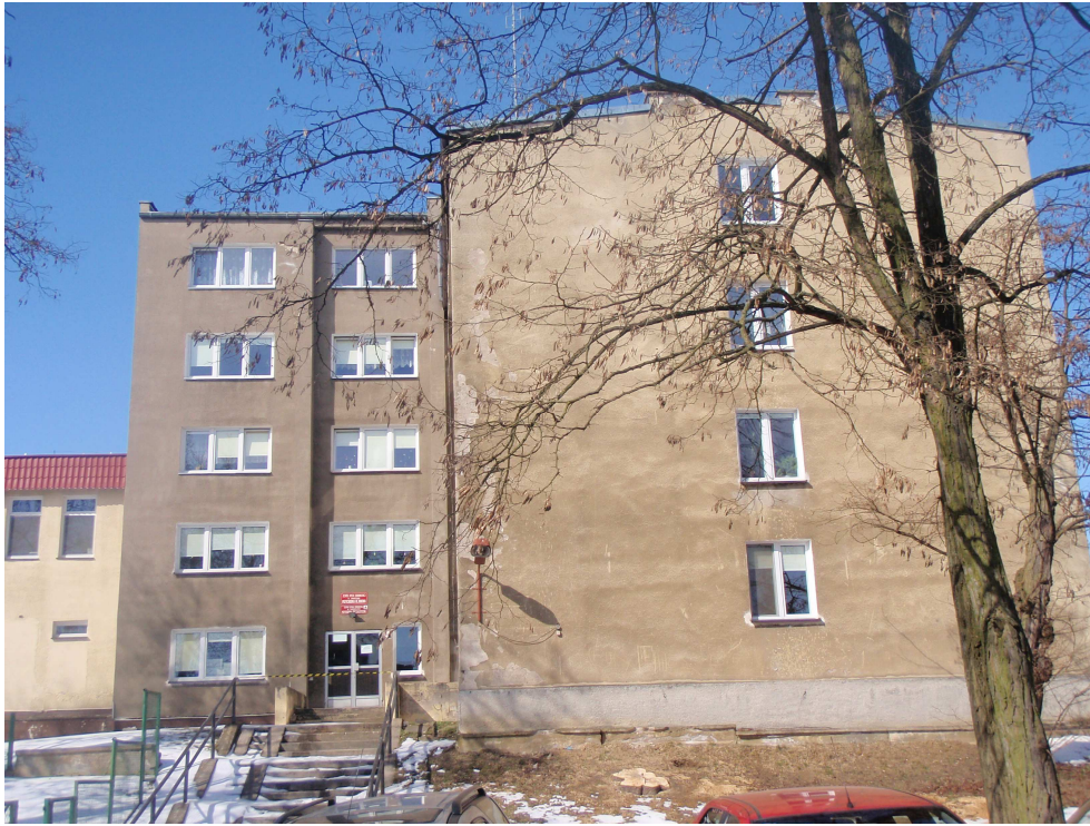
Zdjęcie 3. Widok ściany południowej
