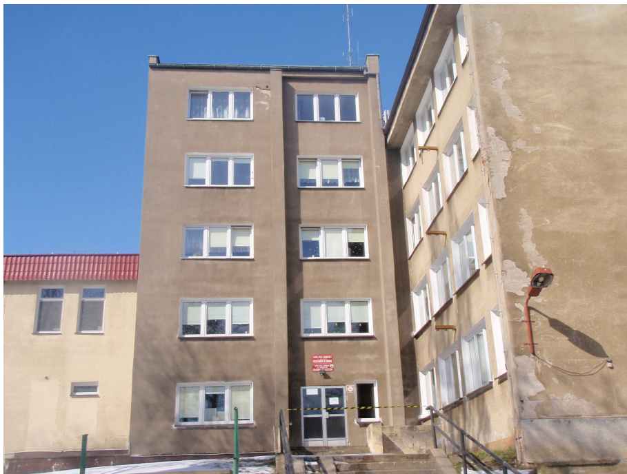
Zdjęcie 2. Widok ściany południowej
