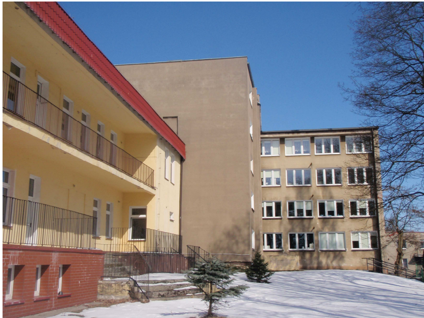
Zdjęcie 1. Widok ściany zachodniej
