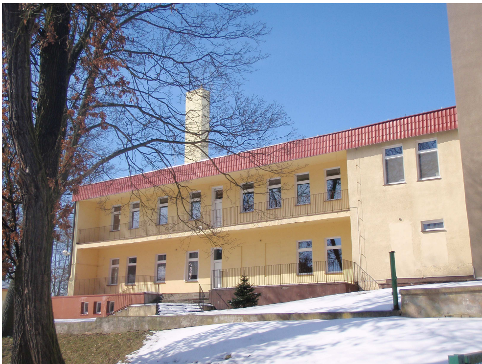
zdjęcie 4. Widok ściany południowej
