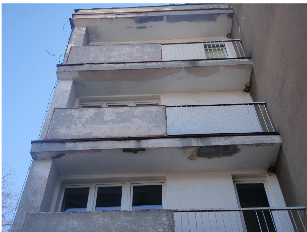
Zdjęcie 8. Widok elewacji zachodniej
